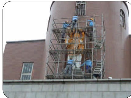
土台をはがす為に電動ドリルやハンマーでご神像の底面をこじあげる
