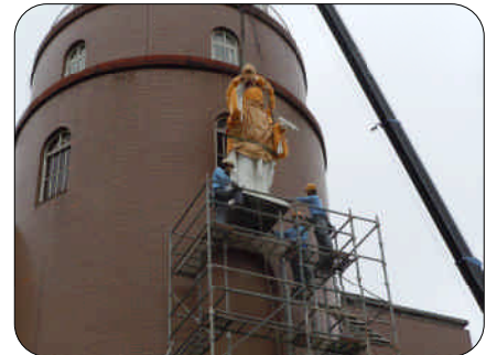
古毛布で顔を覆われたご神像がクレーンで吊り上げられる
